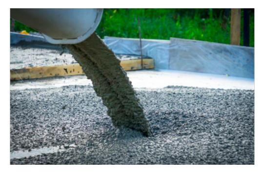
高效减水剂对水泥有强烈分散作用,能较大提高水泥拌合物流动性和混凝土坍落度,同时大幅度降低用水量,明显改善混凝土工作性。但有的高效减水剂会加速混凝土坍落度损失,掺量过大则泌水。高效减水剂基本不改变混凝土凝结时间,掺量大时(超剂量掺入)稍有缓凝作用,但并不延缓硬化混凝土早期强度的增长。能大幅度降低用水量从而明显提高混凝土各龄期强度。在保持强度恒定时,则能节约水泥10%或更多。氯离子含量微少,对钢筋不产生锈蚀作用。能增强混凝土的抗渗、抗冻融及耐腐蚀性,提高了混凝土的耐久性。木质素磺酸盐制备方法:一般主要有两种脱取木质素制造减水剂的方法。缓凝减水剂费用
